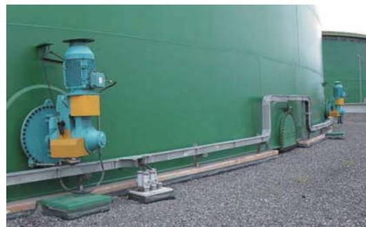
55千瓦摇头式齿轮传动搅拌器，带自动摇头器
