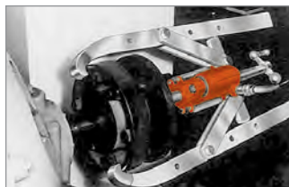
Le raccord flexible est retiré de l'arbre du moteur électrique à l'aide d'un extracteur 2 griffes.
