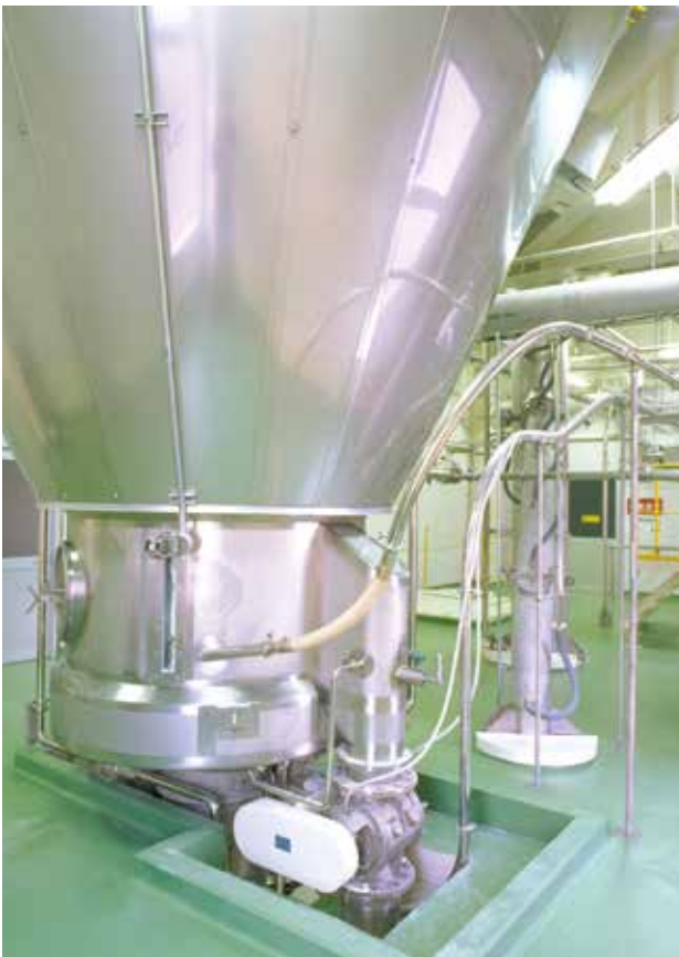
Kammer mit einem integrierten Anhydro Fließbett bed
