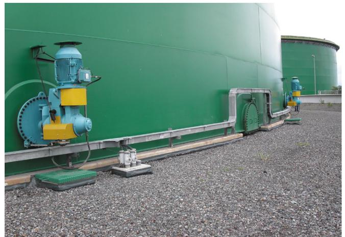
55kW 旋转角度齿轮传动搅拌机，配备自动制动器
