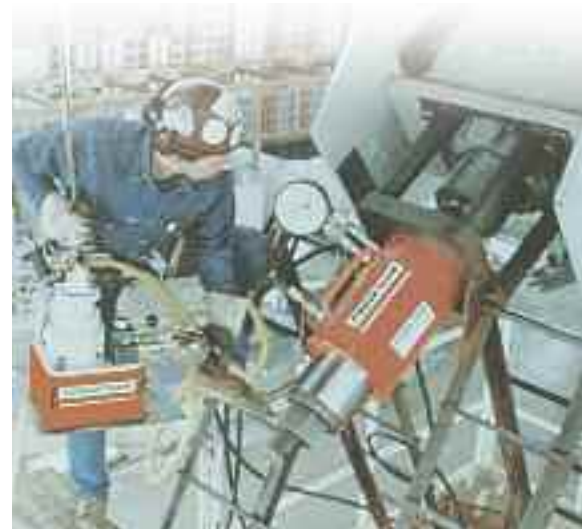
Bomba PA554 e cilindro furo central RH2008 usado em tensionamento de cabo.
