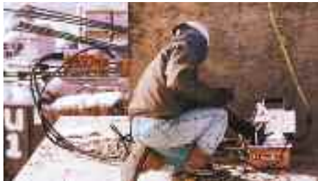
A PE60 usada para pós-tensionamento.
