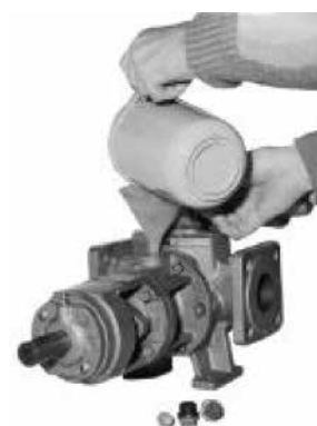
Het vullen van de pomp
