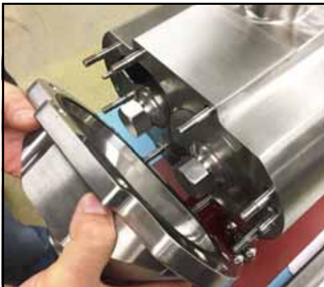
Figure 128 – Installation du couvercle de la pompe
