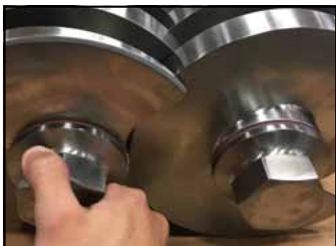
Figure 124 – Installation des écrous de rotor
