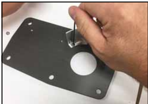
232. ábra – Az oldalkarima-csavarok meghúzása
