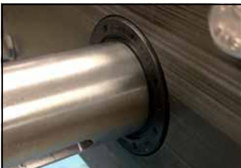
**Figura 239 - Tenuta dell'olio installata**
