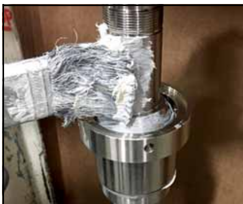
Rysunek 161 — Nakładanie środka antykorozyjnego na wał
