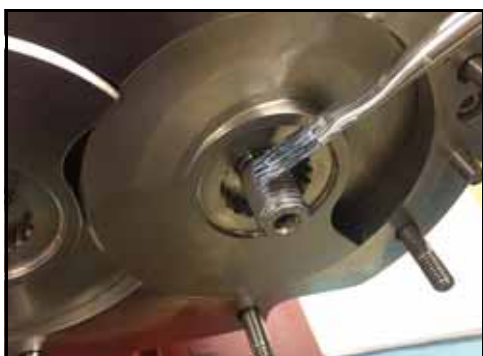
Rysunek 118 — Nakładanie środka antykorozyjnego
